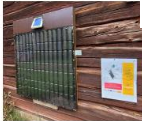
Yhteisessä työpajassa rakennettu aurinkokerääjä kiinnitettynä kylätalon seinään.
